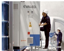
Instalado com base
